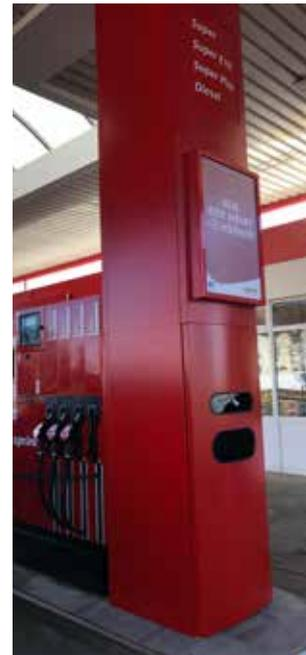
**Abbildung 2:** Sortenkennzeichnung in der Säulenverkleidung integriert
