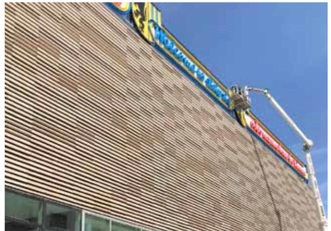
**Abbildung 4:** Montage Historische Werbeanlage Höfe am Brühl Leipzig (Länge 95 m, Höhe 5 m, Gewicht 45 t )
