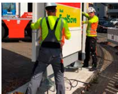
Preismastmontage auf von CARALUX geplantes Fundament inkl. Ankerkorb
